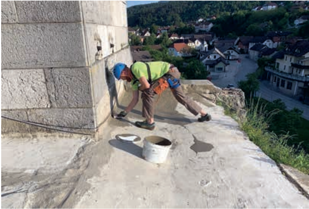
Steber viadukta - izvedba zaščitnega premaza.
