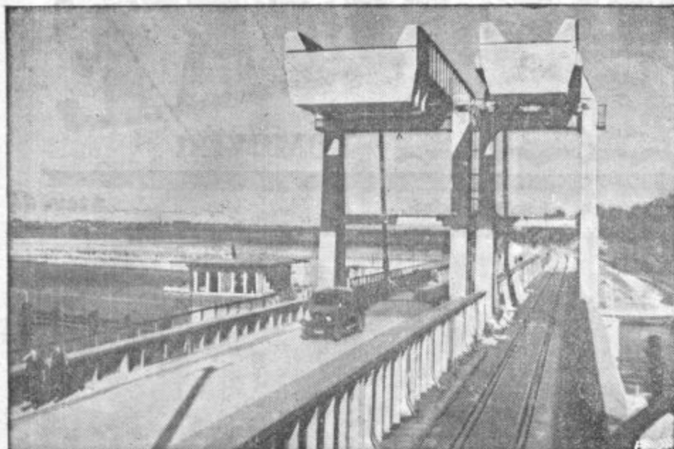
NEMCIJA SE JE Približala SKANDINAVIJI. Tri leta so Nemci gradili 2 in pol km dolg železniški nasip do otoka Rujane (Rügen). Ta nasip je skrašal železniško zvezo med Nemčijo, Švedsko in Norveško za dobre tri četrt ure.
