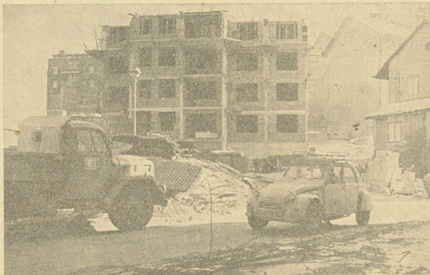
Stanovanjska skupnost Trbovlje je pred nedavnim pričela graditi dva nova stanovanjska bloka na območju Polaja v Trbovljah. Na fotografiji je posneta gradnja bloka S-50.
