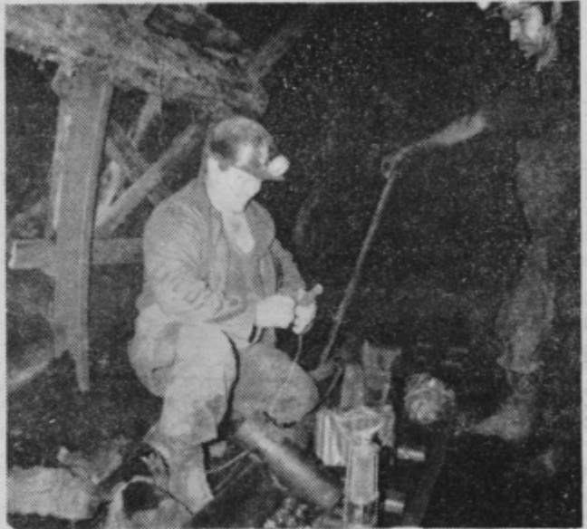
V debelem »flecu«. Rudar v odkopnem oknu odkopuje sloj kvalitetnega rjavega premoga. Opaž, ki varuje delavce pred vdori je lesen.
