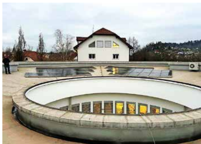
Malo fotovoltaično elektrarno so postavili tudi na streho Knjižnice Medvode. / Foto: arhiv Občine Medvode
