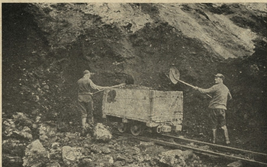
Pred 30. leti so premog na površinskem kopu Dobrna nakladali tudi s »pik asi« v lesene vozičke. Sedaj pridobivajo premog z buldožerji, nakladalci, odvažajo ga z avtomobili, itd.
