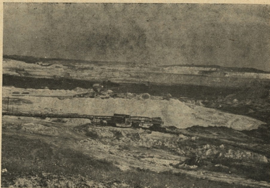
Površinski kop premoga na polju D REIK-Kolubara, s transportnima postajama. Zadaj sloj premoga.
