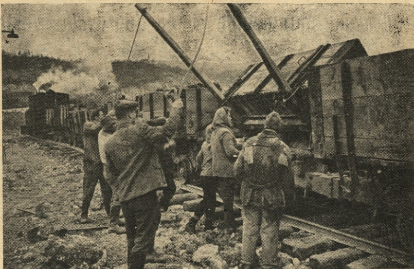
Transport nakopanega premoga in jalovine je na površinskem kopu Dobrna pred tremi desetletji potekal tako kot kaže gornja slika. Vozički so bili nekoliko večji in so jih imenovali »lore«.
