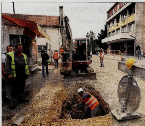
Na Cesti Leona Dobrotinška so se lotili prenove celotne komunalne infrastrukture.
