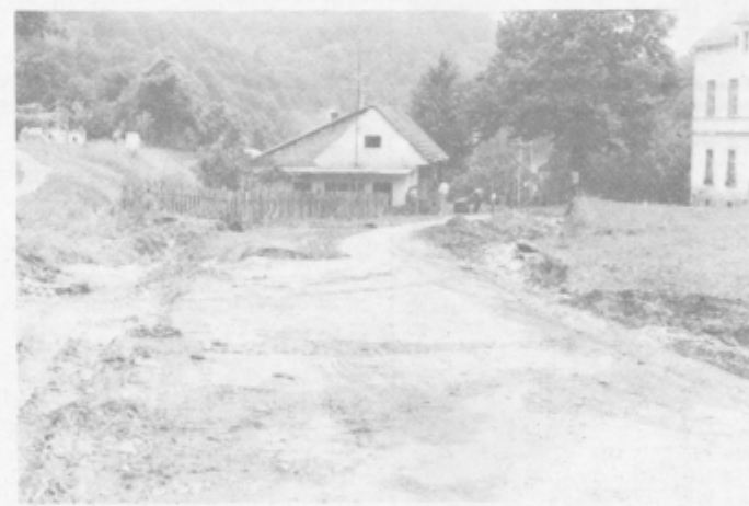
Cestarji so takoj pričeli obnavljati cesto v Narapljah.
