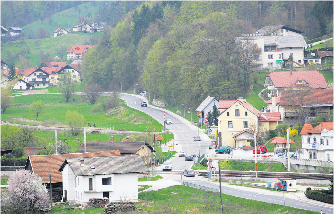
Po izgradnji nadvoza bo železniški prehod na zelo prometni dvotirni progi Zidani Most–Šentilj ukinjen, ostala prehoda bo cesta obšla, tako da vlaki prometa na Grobelnem ne bodo več ovirali. Nova cesta bo vodila levo od obstoječe ceste, objekti v spodnjem levem kotu fotografije so že porušeni. Rok za končanje del je sicer konec avgusta leta 2015.
