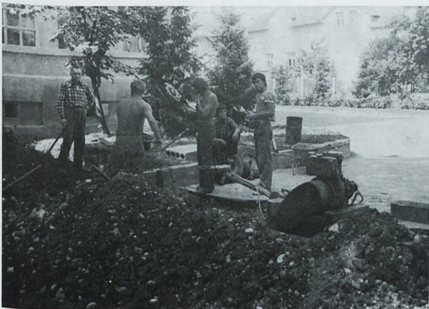
Takole so prekopali dvorišče, da so položili kanalizacijo
