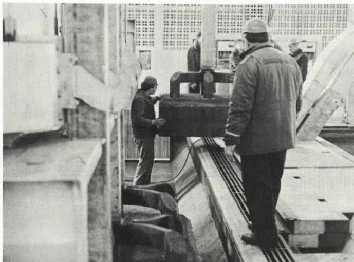
Montaža anodnega bloka
