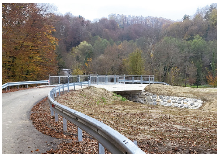
Izgradnja novega mostu v Dolanah po neurjih v letu 2023
