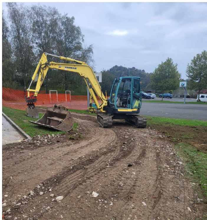
Ob začetku gradbenih del pri Športni dvorani Cirkulane
