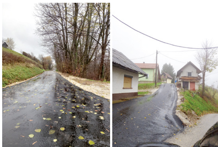
Nova pridobitev v Vaškem odboru Mali Okič - Slatina je posodobljeni odsek ceste Mali Okič od hišne številke 1 do 3. Foto: arhiv VO
