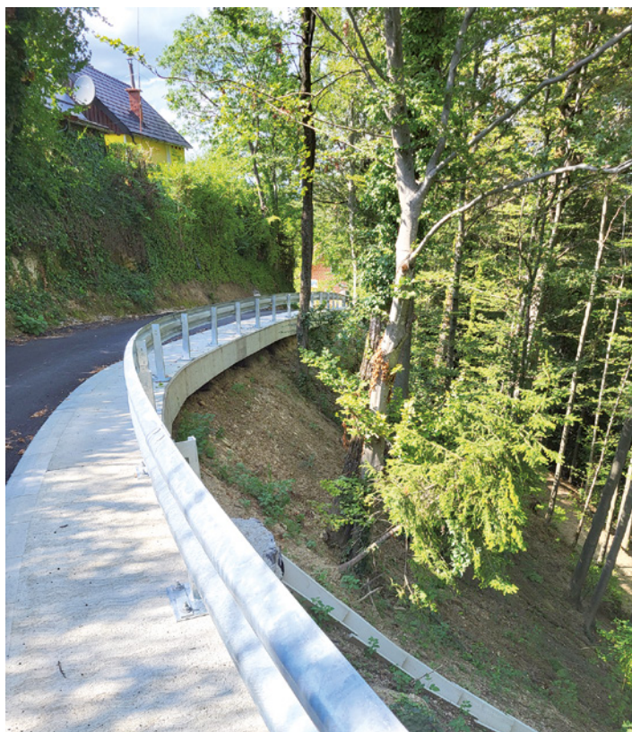
Sanacija cestnega odseka in plazu v Pohorju
