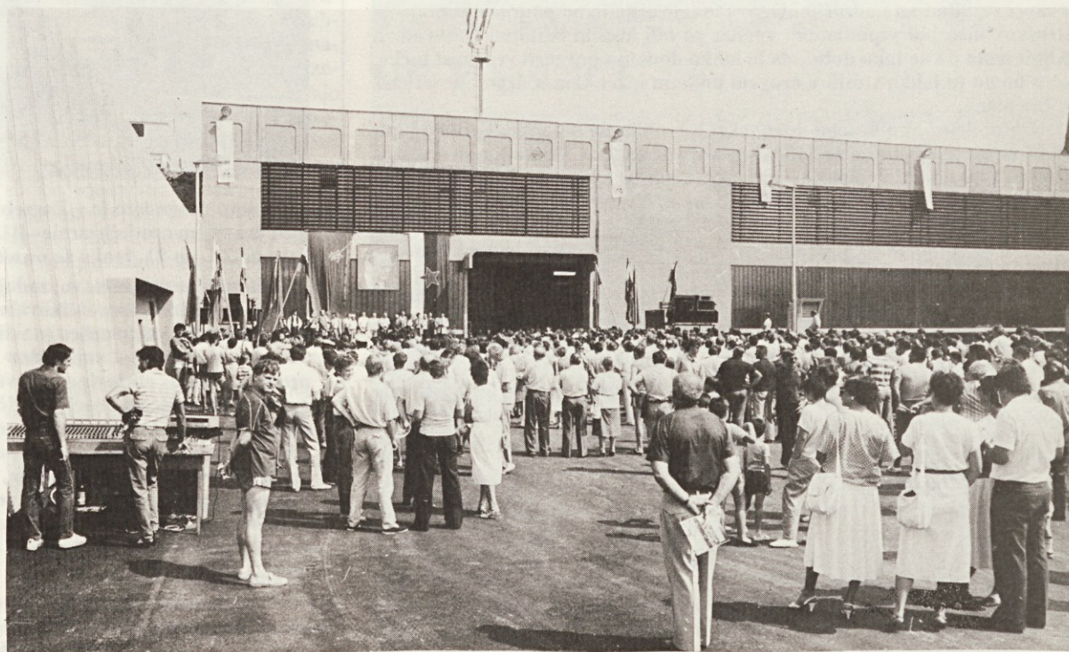
Otvoritvi nove hidroelektrarne v Mavčičah je prisostvovala množica ljudi. (Foto: B. Francelj)
