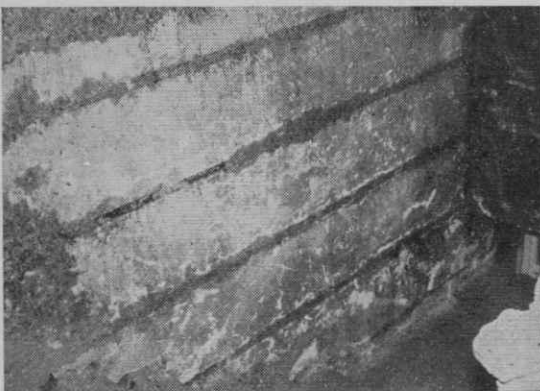
Sl. 11. Gruberjeva palača, podstrešje, fugiran omet na stopniščni strani južnega zidu, jugovzhodni del
