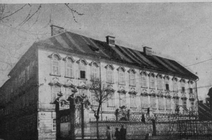
Sl. 1. Gruberjeva palača — zahodna fasada
