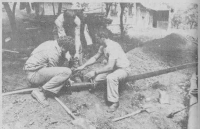
Delavci Komunalne, gradbeništv in prometa iz Ptuja za brigadirji sproti polagajo vodovodne cevi.
