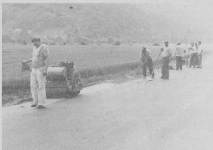
Delavci Cestnega podjetja Maribor med urejanjem bankin na prenovljenem odseku ceste Hajdina—Macelj.
