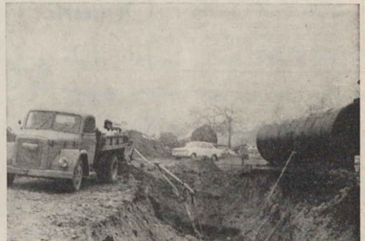
Dela pri gradnji bencinske črpalke v Polju hitro napredujejo. Črpalka je za današnji motorizirani svet že kar nuja
