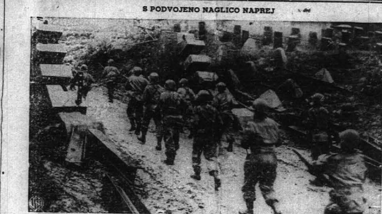
To je zmajevo soborje baje neprodirnih betonskih in jeklenih utrdb na nemški Siegfriedovi črti. Pošči ameriške 90. divizije se podvzajajo na potu, ko ravno nameravajo zavzeti mesto Habscheid.
