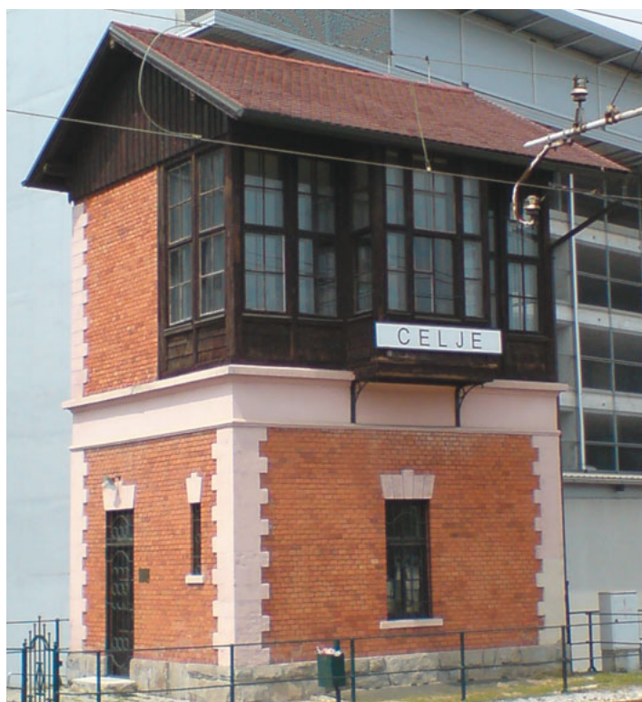
Obnovljeni kretniški stolp 2 na železniški postaji Celje se kot tehniški spomenik lokalnega pomena vodi v zbirnem registru dediščine pod evidenčno številko EŠD 3057 (Foto: Mladen Bogić)
