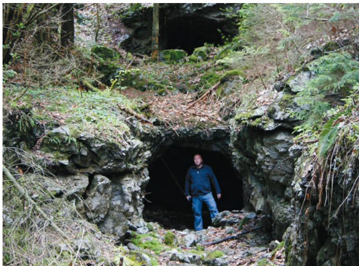
Nedokončani južni portal zgornjega godoviškega železniškega predora. Po izkopni metodi, ki je bila tedaj (med prvo svetovno vojno, pa tudi prej) v rabi, so napravili izkopni rov (zgoraj) in izvozni rov (spodaj). (Foto: Peter Gedei)
