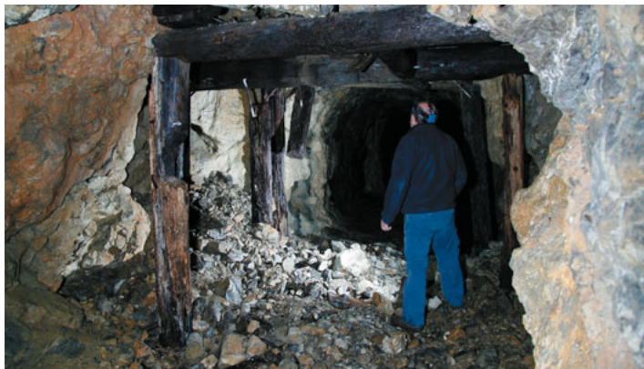
Izvozni rov v zgornjem godoviškem železniškem predoru le na nekaterih mestih ni bil dovolj stabilen, in ga je bilo treba podpreti. (Foto: Peter Gedei)
