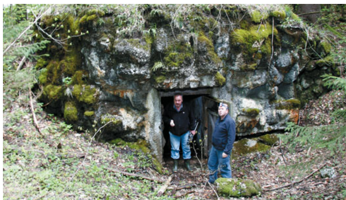
Le nekaj deset metrov od ceste Godovič–Črni vrh, vzhodno od nje in nekaj metrov niže je v vrtači takole kamufliran zgornji vhod v italijansko utrdbo iz obrambnega sistema Vallo Alpino. Spustimo se po stopnicah in že smo v jedru utrdbe, ki je svoje mesto našla v nedograjnem zgornjem godoviškem železniškem predoru. (Foto: Peter Gedei)
