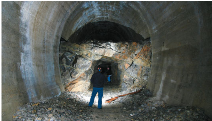
Del končanega zgornjega godoviškega predora (zbetonirana kalota), kakih 150 metrov od južnega portala. V ozadju je zgornji del oboka že dokončan, spodnji del predora pa še ne odstrljen. (Foto: Peter Gedei)
