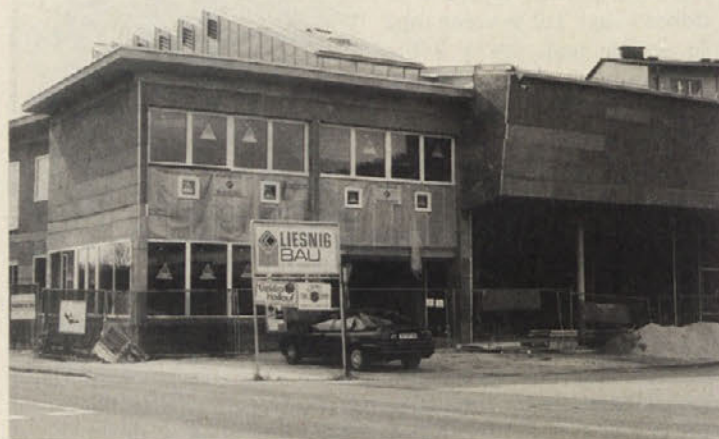
Pogled na zgradbo KD s severne strani
