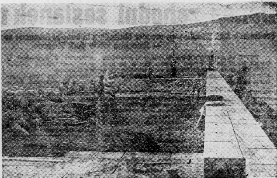
Po daljšem presledku nadaljujejo obnovitvena dela na valobranu koprski potniške luke. Dosedanja obnova valobrana, ki ga je, že načrtoval od časa, dokončno razdelalo hudo neurje 14. avgusta 1957, v dolžini 81 m, je stala 20 milijonov din. Ureditev vrhnje ploščadi in napeljava električnega kabla ter vodovoda — podjetje »Konstruktor« z Reke naj bi ta dela končalo do sredine januarja — pa bo terjala nadaljnjih 10 milijonov din. Ob notranji strani valobrana je globina morja 4,5 do 5,5 metra, tako da se uporablja valobran tudi za pristajanje ladij. Ko bo na razpolago denar, pride na vrsto še druga etapa obnove v dolžini 60 m. Mimogrede naj omenimo, da je raven nove ploščadi morda le preizkusa, saj jo morje večkrat preplavi. Zlasti to jesen se je tako že kaj pogosto zgodilo, ker so plime izredno visoke. Dne 11. t. m. je bila na primer nova ploščad 30 cm pod vodo. (Foto: Frenk)
