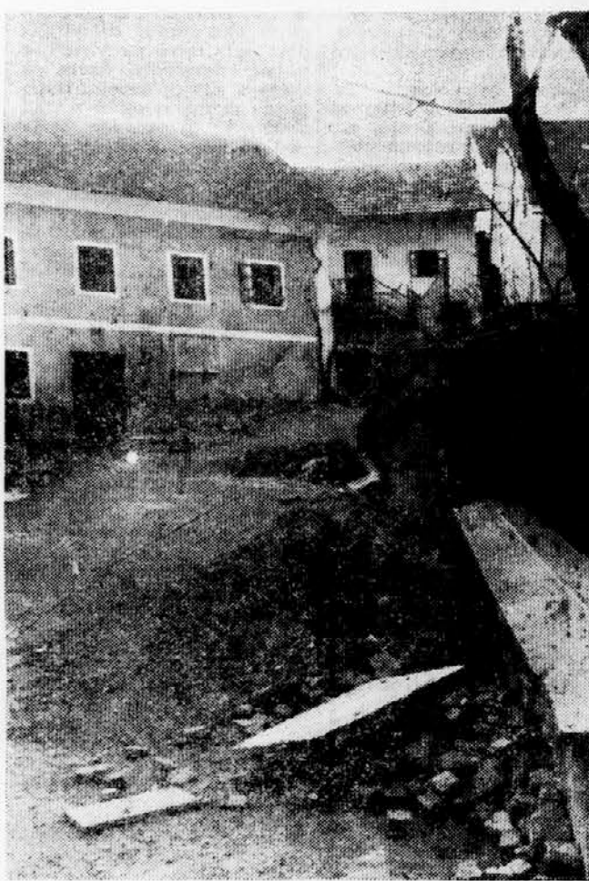
UREJANJE KLANCA — Napeljevanje kanalizacije in asfaltiranje Klanca od Cankarjeve rojstne hiše bo kmalu končano, v zaključni fazi je tudi obnova notranjosti hiše. To bo eden prvih prispevkov ob obširnim pripravam na proslavo ob 50-letnici pisateljeve smrti. Foto: B. C.
