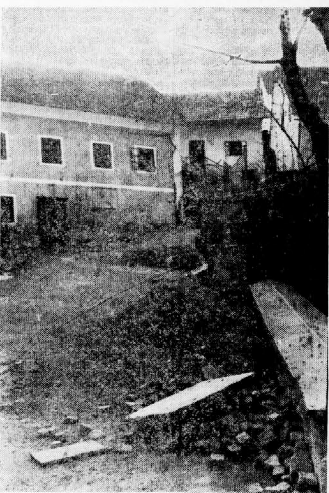
UREJANJE KLANCA — Napeljevanje kanalizacije in asfaltiranje Klanca do Cankarjeve rojstne hiše bo kmalu končano, v zaključni fazi je tudi obnovevanje notranjosti hiše. To bo eden prvih prispevkov k obširnimi pripravam na proslavo ob 50-letnici pisateljeve smrti. Foto: B. C.
