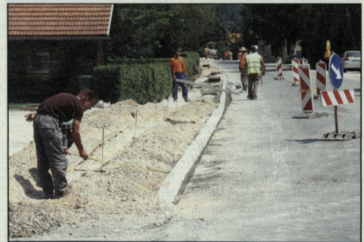
Gradnja pločnika v naselju Parižlje
