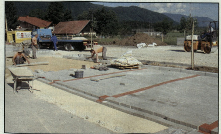
Gradnja parkirišča pri braslovškem pokopališču
