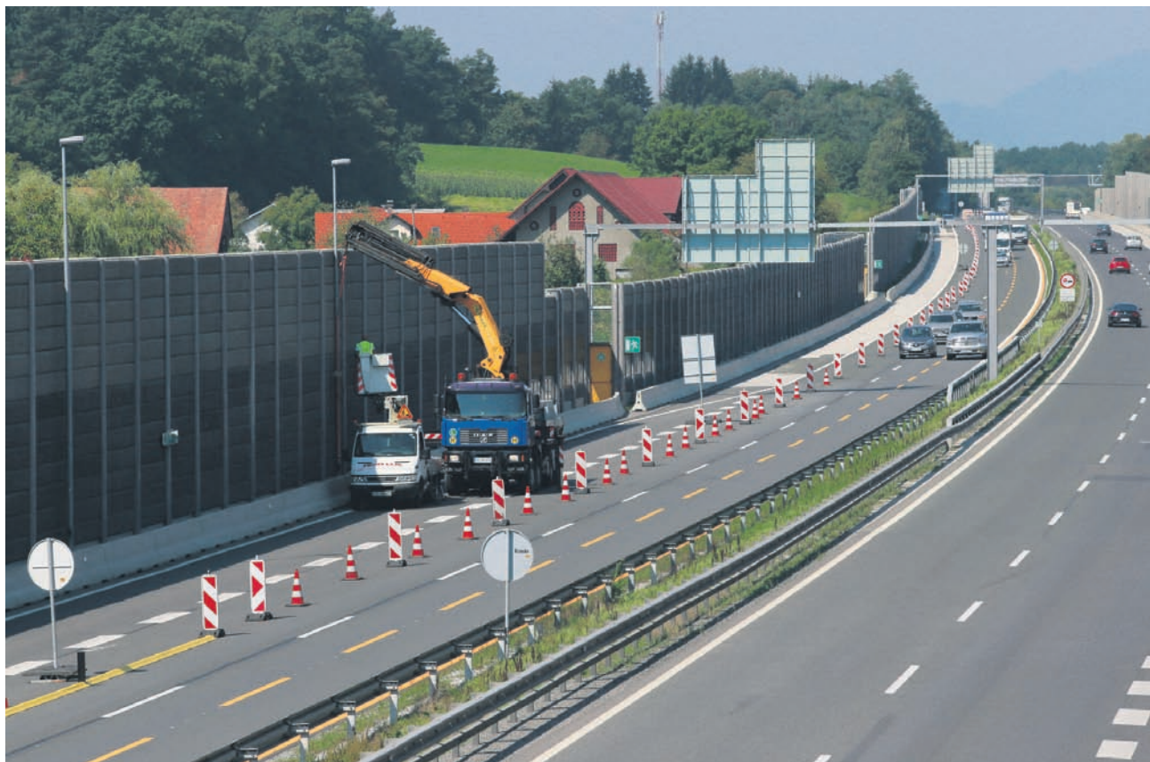
Menjava protihrupnih ograj na štajerski avtocesti na odseku Dramlje–Celje–Arja vas v smeri proti Mariboru.
