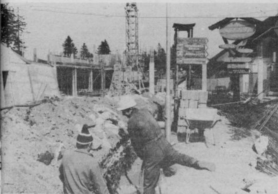
Gradbišče na Rogli
