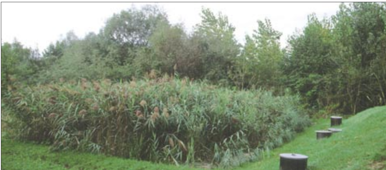
Slika 3: Rastlinske čistilne naprave so preizkušena, cenovno ugodna in estetska okoljska tehnologija za čiščenje različnih vrst odpadnih voda. Prikazana je uporaba RČN za izcedne vode na odlagališču odpadkov na Ljubljanskem barju (foto: Bogdan Macarol).
