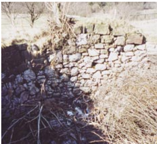
Slika 3: Edina (delno) ohranjena ledenica v Velikih Ločah (na sliki 2 označena s številko 1). Ledenica leži na območju kontaktnega krasa, kar se odraža tudi v njenem gradbenem materialu (bel - apnenec, rjav - fliš). Izbrana ledenica leži v Velikih Ločah (občina Hrpelje-Kozina, v krajevni skupnosti Slivje).
