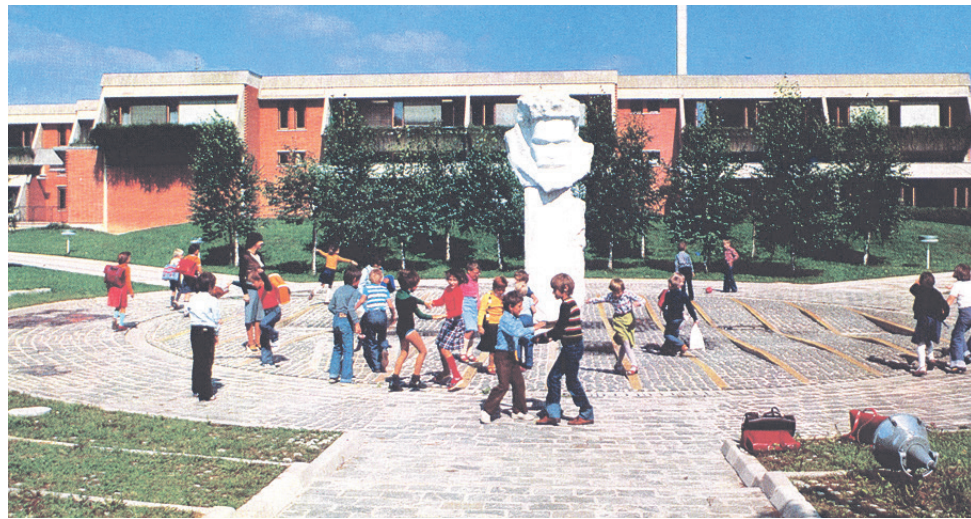
Nekdanja OŠ Slavka Šlandra, zdajšnja II. osnovna šola Celje, je delo Ravnikarjevega študenta Mirana Polutnika, ki je imel čut za primerno postavitev stavbe, pravilne materiale in kako napraviti šolo takšno, da je bila otrokom in učiteljem prijazna. Žal se je z obnovo marsikaj pokvarilo. (Foto: Občinska skupščina in Turistično društvo Celje, Spektar Zagreb. Monografija Celja. Ljubljana: ČZP Delo, 1978)
