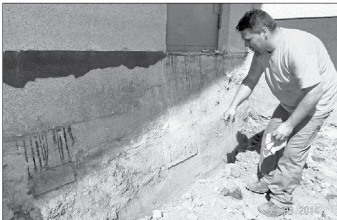
Pri delih so našli temelje nekdanjega gasilskega stolpa in napisno tablo z letnico 1909 ter napis o kritični višini vode z datumom 25. oktober 1964.
