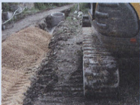
Še letos bo zgrajena kanalizacija s čistilno napravo v Padni, v Novi vasi pa bomo čistilno napravo zagnali v petek. Tako bodo s kanalizacijo opremljene prav vse krajevne skupnosti v Občini Piran.
