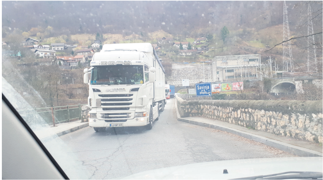
Z novo cesto se na odseku Hrastnik–Zidani Most obetajo štirje novi mostovi, eden tudi preko Savinje.
