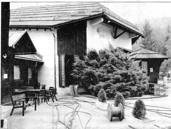
Delavca, ki sta na Golteh napeljevala novo nosilno vrv, sta padla 10 metrov v globino in se smrtno ponesrečila (foto: EMS)
