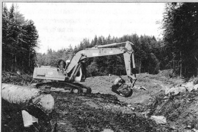
Medtem ko na plazu potekajo sanacijska dela, se strokovnjaki in občina pogovarjajo o rešitvah, ki so za javnost ostale skrite (foto: Ciril M. Sem)
