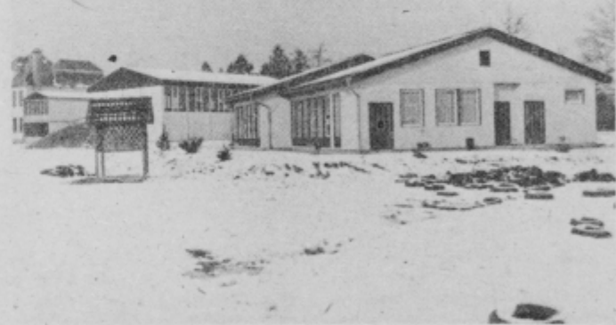
Obnova stare osnovne šole, v prizidku nova sodobna telovadnica in ob njih še vrtec na Pragerskem so uresničitev iz preteklega samoprispevka.
