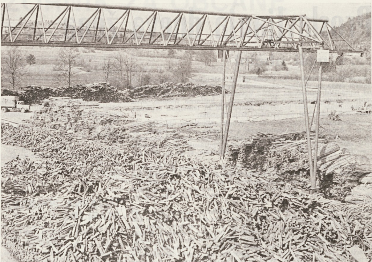
Skladišče nove tovarne ivernih plošč v Podskrajniku
