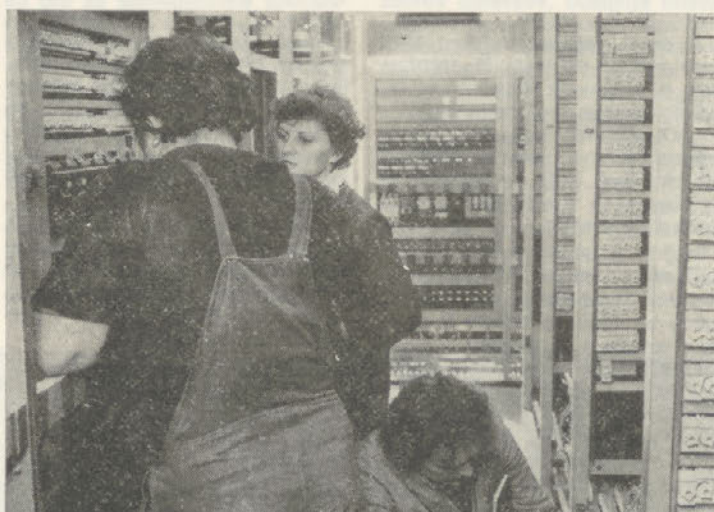
Elektrovzdrževalci med zahtevnim delom
