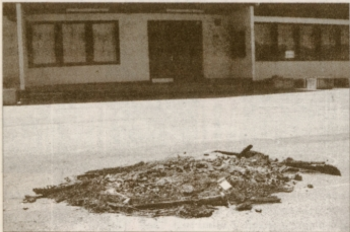
Ostanki hišice po požaru.
