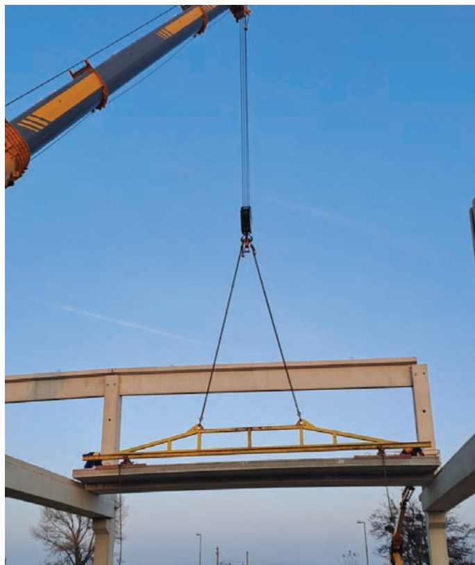
Slika 9. Montaža prednapetih votlih plošč z dvížnimi klešči.
