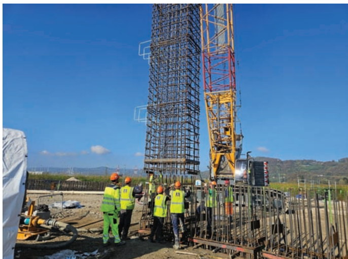
Slika 5. Podaljševanje košev primarnega panela (do skupne globine 64 m).
