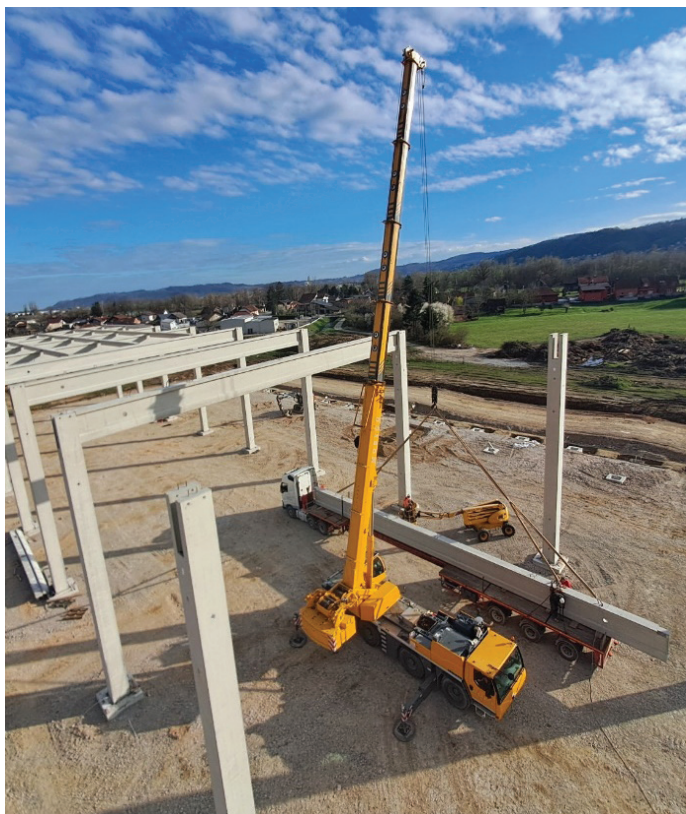
Slika 5. Pri montaži primarnih nosilcev je treba zagotoviti dvigalko, da se postavi na sredino pozicije nosilca (med stebra). Kamion se postavi ob dvigalko, nato se začne dvig.
