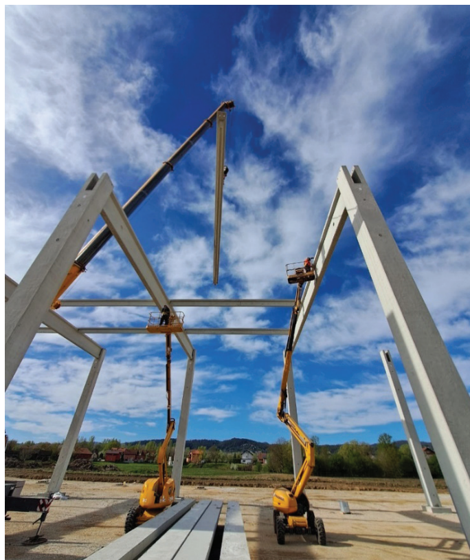
Slika 6. Montaža sekundarnih nosilcev.
