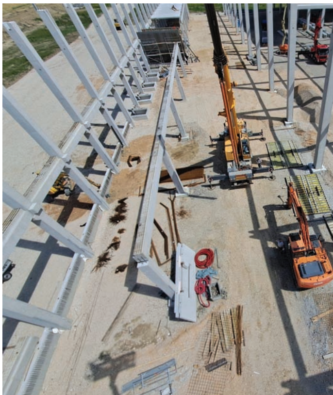
Slika 8. Po montaži medetažnih gred je treba grede monolitizirati, da jih zaščitimo pred rotacijo ob montaži prednapetih votlih plošč.
