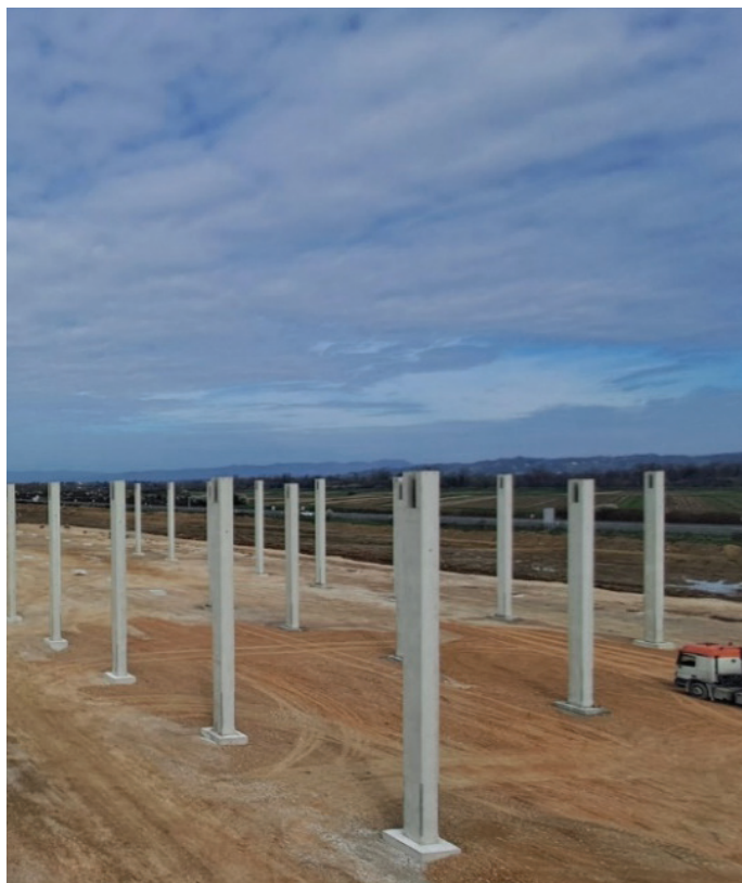
Slika 3. Delno postavljeni prefabricirani AB-stebri.
