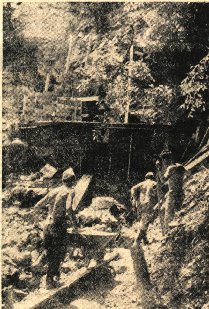
V Bohinjski Bistrici gradi komunalna uprava vodovod, ki bo končan najkasneje do dneva republike. Novo vodovodno omrežje, ki bo priključeno na staro, bo dolgo nad tri kilometre. Na sliki: dela pri zajetju Bohinjske Bistrice
