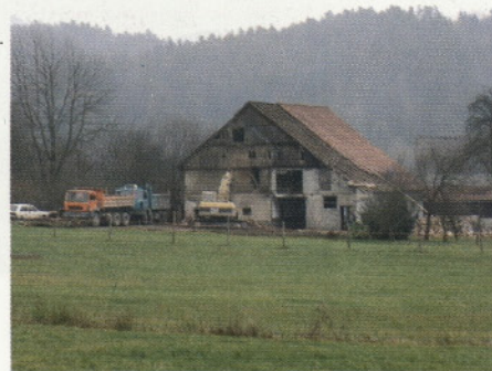
Gradbeni stroji sredi dela.
