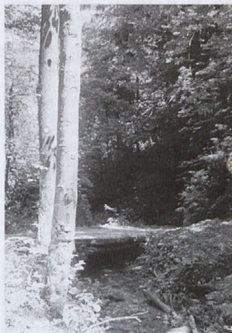
Ena izmed makadamskih poti in leseni most - oba večkrat poškodovana ob večjih nalivih in spravilu lesa iz gozdov.
