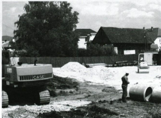
Izkopi za nov bencinski servis.
