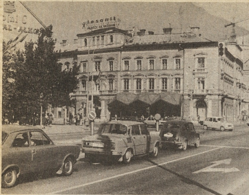
Na zunaj se Kavarna Evropa ne bo spremenila, saj je stavba spomeniško zaščiten. Le vhodi bodo na mestih, kjer so nekoč že bili: z vogalov Titove in Gosposvetske ceste.
