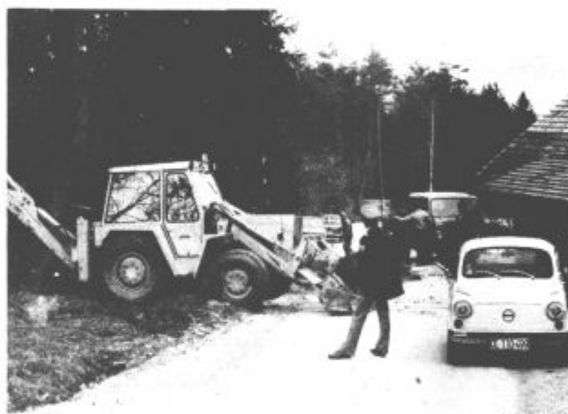
Zasutje gradbene jame
