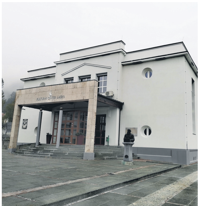
Kulturni center Laško je energetsko prenovljen. (Foto: BA)
