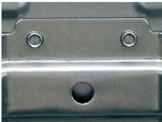
» Zveza pločevin z okroglima točkovnima spojem Tox
