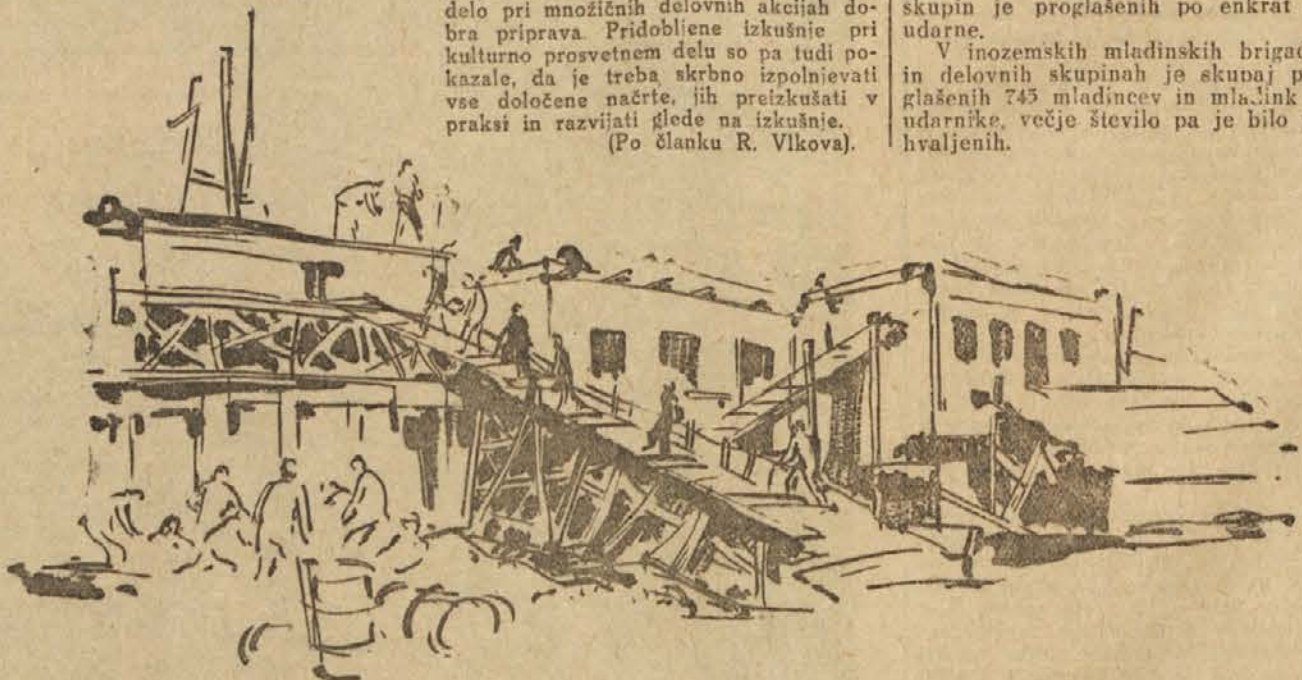
Gradnja nove potniške postaje v Zenici.
