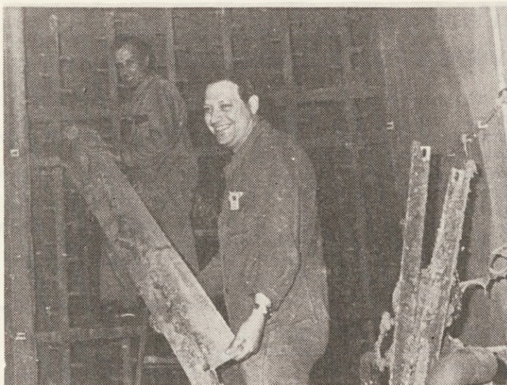
Dane Bitenc in Nace Jerant zamenjujeta iztrošene usmerjevalce zraka v centrali klime za predpredilnico bombaža.
