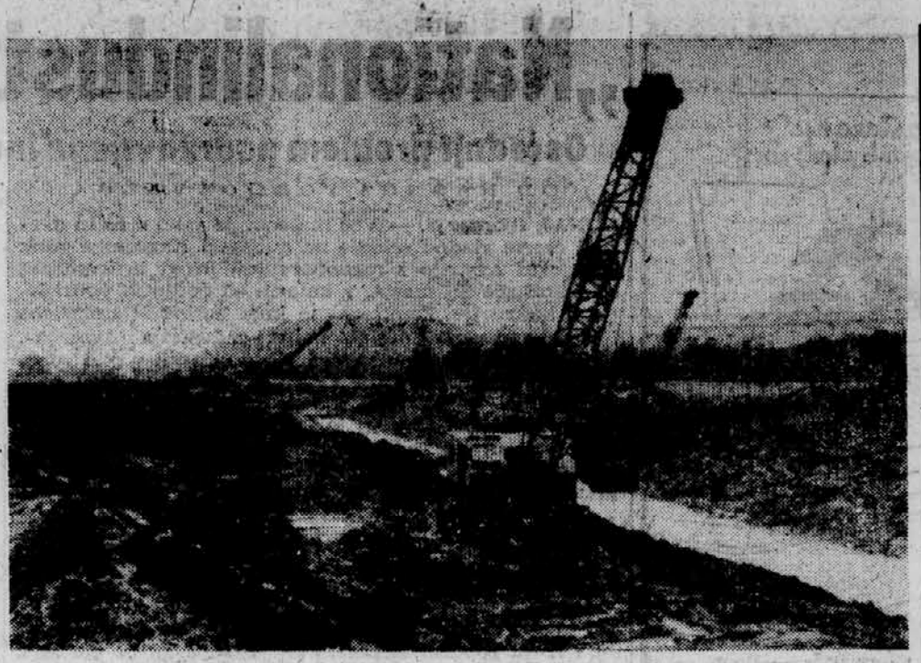
MRAZ NI OVIRA ZA GRADITELJE — Čeprav že od zlatih dni januarja mraz precej krepko pritiska, dela na velikem gradbišču HE Srednja Drava niso zamrla. Graditelji so vsi zimo kopal odvodni in dovodni kanal, z nastopom pomladi pa bo to gradbišče še bolj zaživelo. Foto: J. P.
