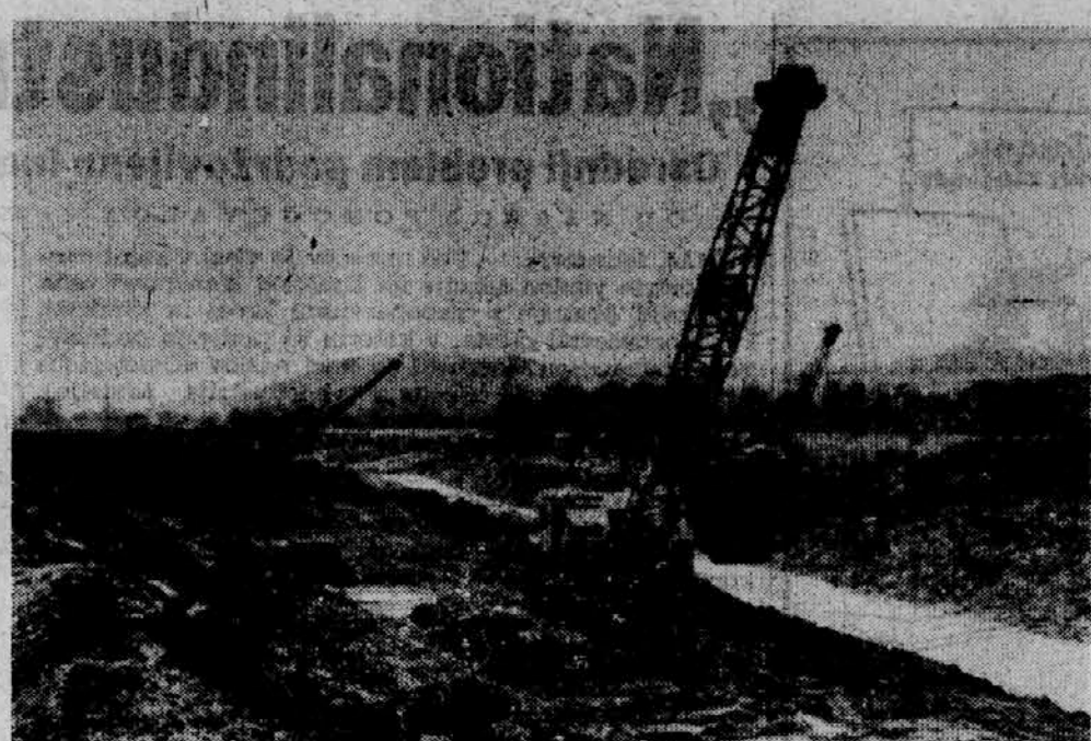
MRAZ NI OVIRA ZA GRADITELJE — Čeprav že od zadnjih dni januarja mraz precej krepko pritiska, dela na velikem gradbišču HE Srednja Drava niso zamrli. Graditelji so vso zimo kopal odvodni in dovodni kanal, z nastopom pomladi pa bo to gradbišče še bolj zaživeło.
