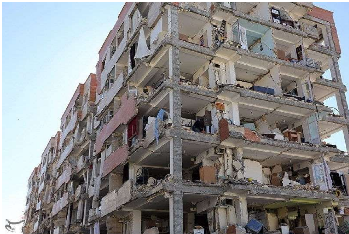
Slika 3. Poškodovan blok v iranskem mestu Sarpol-e Zahab (Vir: https://commons.wikimedia.org/w/index.php?curid=64039672 )
