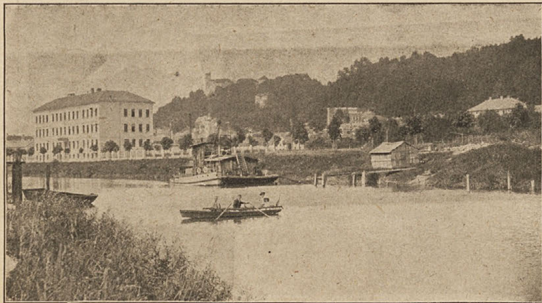
Dela v Ljubljaničini strugi: Na Prulah. (V ozadju nova šola na Prulah in Ljubljanski grad.)
