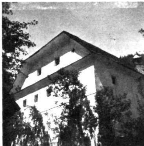
Dvonađstropna zidana hiša na Zalem logu št. 35
