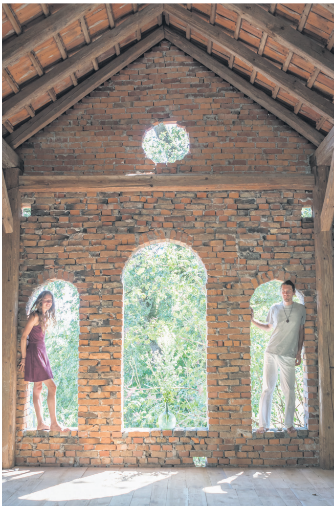
Obnovljen prostor na skednju za izvajanje srečanj in delavnic.
